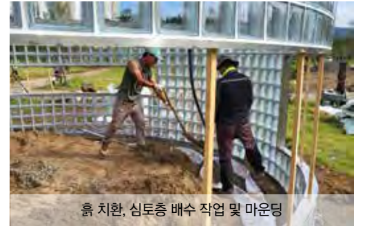
기초 콘크리트 후 유리블럭 프레임 설치
