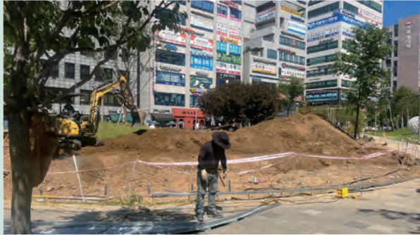
SITE 1. '오리엔탈 포레스트' 조성 현장
