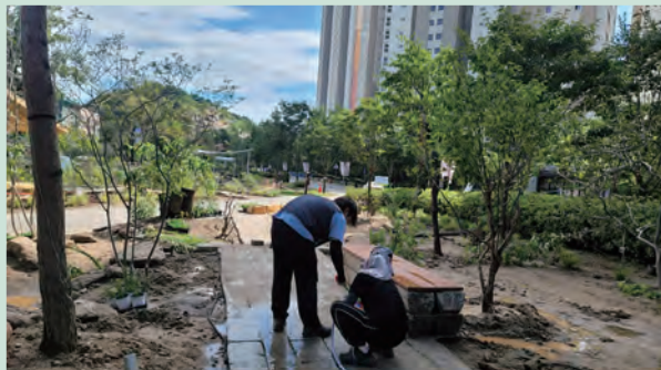
SITE 3. '숲을 거니는 시간' 조성 현장
