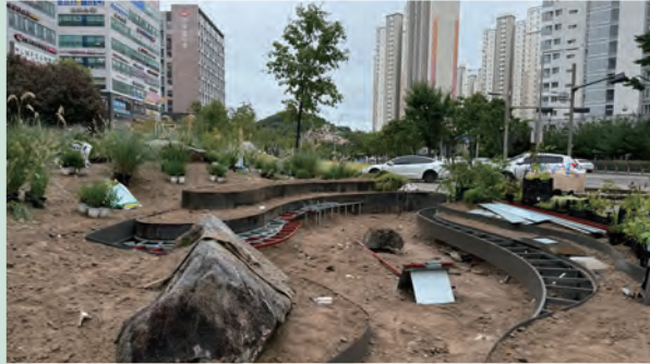
SITE 1. '오리엔탈 포레스트' 조성 현장
