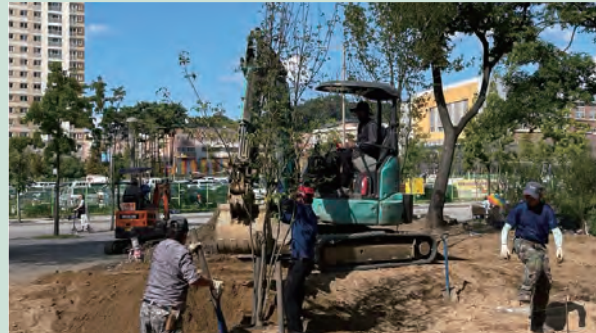
SITE 5. '너덜강-다산의 웁기' 조성 현장
