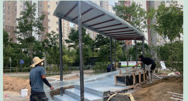
SITE 5. '너덜강-다산의 웁기' 조성 현장
