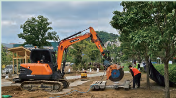
SITE 3. '숲을 거니는 시간' 조성 현장
